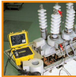
Pomiar przekładni na transformatorze prądowym
